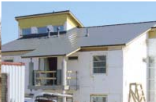
Kohde 22 ennen eristerappausta.
