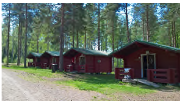
Kuva 13. Alueelle 1990 –luvulla rakennettuja lomamökkejä.
