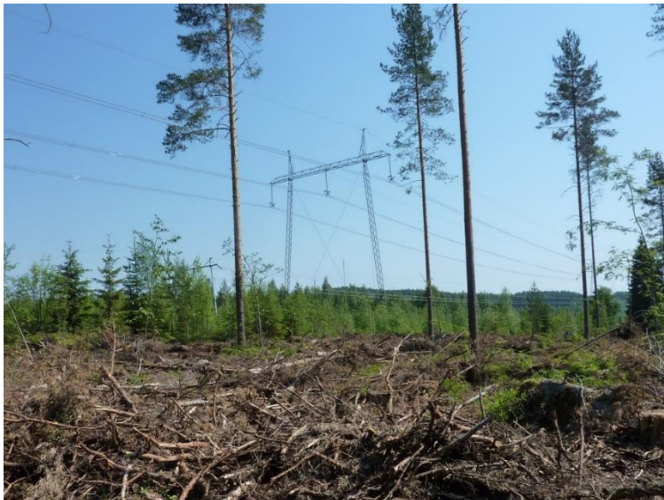
Kuva 19. Suunnittelualan halki kulkeva 400 kV:n sekä sen takana oleva 110kV:n voimajohto.
