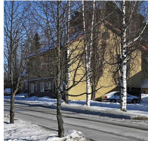
Kuva: Talo rajaa hyvin katutilaa.
