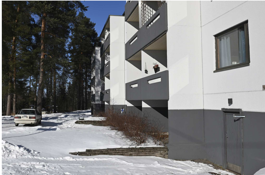
Kuva: Aukolliset betonikaiteet, kantavat pieliseinät.
