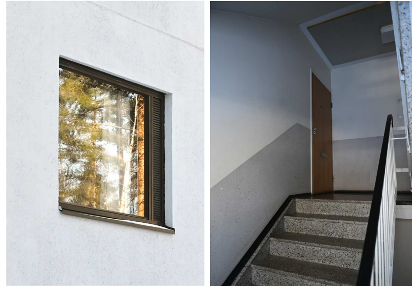
Kuvat: Jaoton ikkuna, jossa ritilällä varustettu kapea tuuletusikkuna. Kaksivartinen suora porras, vakiomallinen teräspinnakaide.
