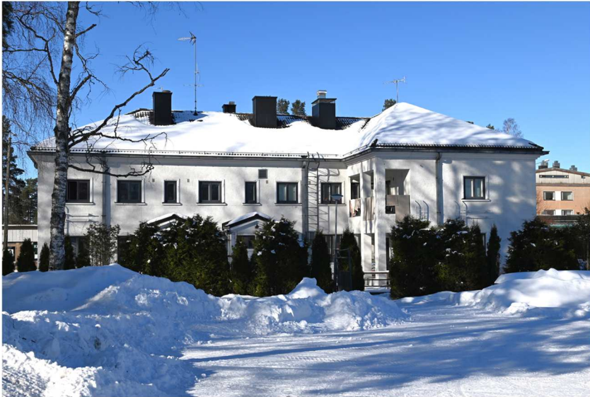
Kuva: Julkisivu radan suuntaan. Pieni umpikuisti. Vinkkelin sivuseinällä on veranta ja parveke sekä myöhemmin lisätty terassi.
