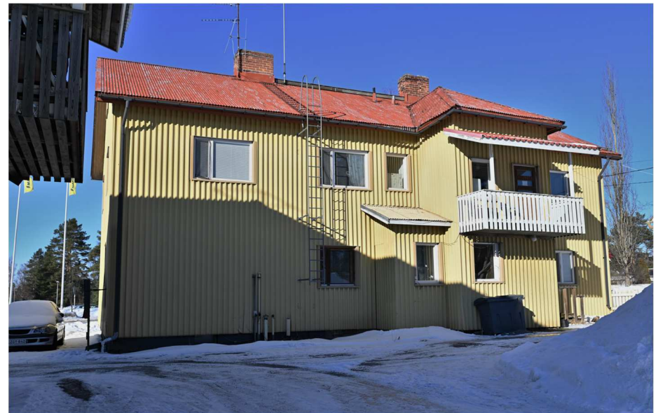
Kuva: Aunuksen pihan puoleinen julkisivu. Porrashuone on ulkonevan poikkipäädyn kohdalla. Aukotukseen on tehty muutoksia.
