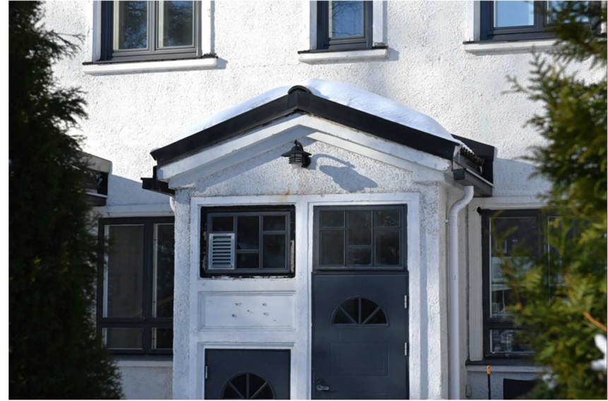
Kuva: Alakerroksen ikkunat ovat vanhat kunnostetut. Muut ikkunat ja ovet on uusittu.
