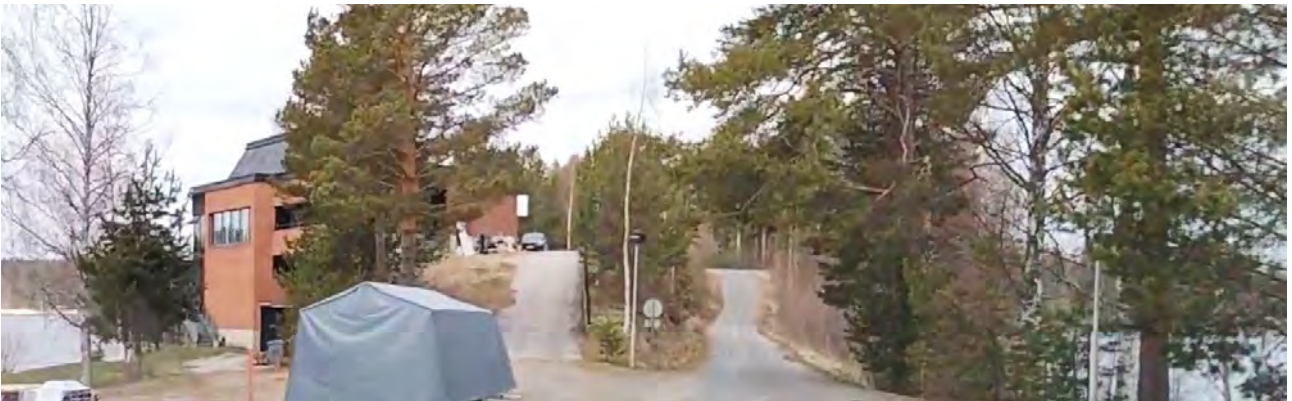
Kuva 12: Ravintolarakennus etelästä. Tietä on ravintolan rakentamisen jälkeen siirretty rakennuksesta kauemmas ja alemmas (kuvassa oikealle).
